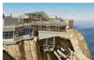
Das Projekt Foto: Stahlbau Pichler
