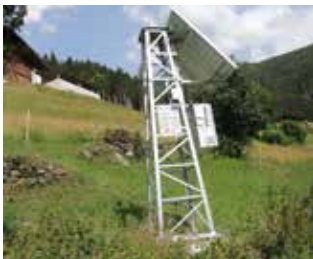
Langzeitmonitoring von großflächigen Rutschungen mittels integrierter Sensor- und Netzwerksysteme (Foto: LPA)
