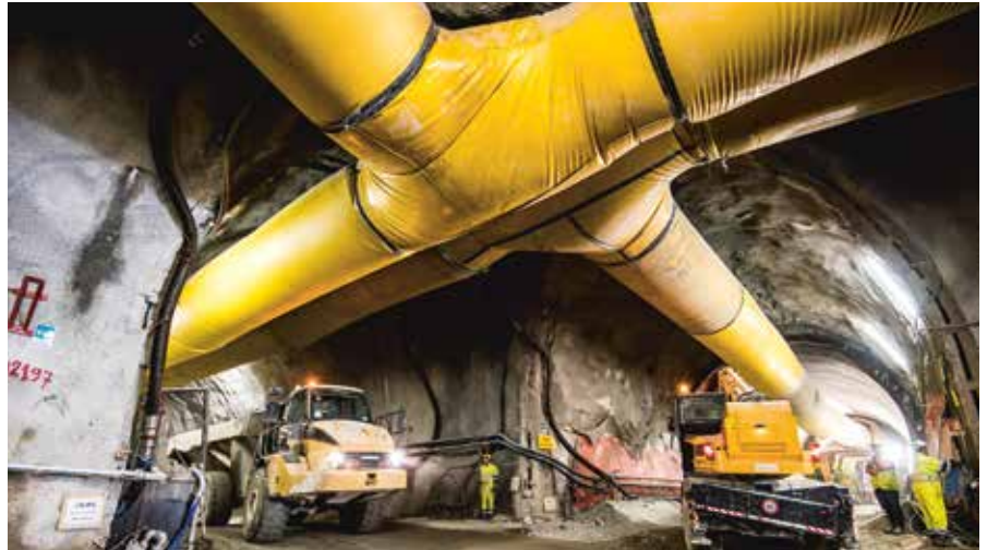
Im Berg entsteht ein System aus Tunneln.
