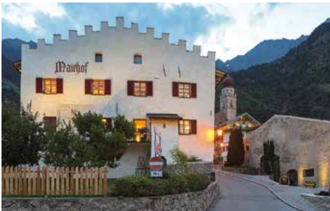
Architekt Manuel Benedikter hat den erstmals 1357 erwähnten Mairhof mit zeitgenössischen Elementen saniert.
